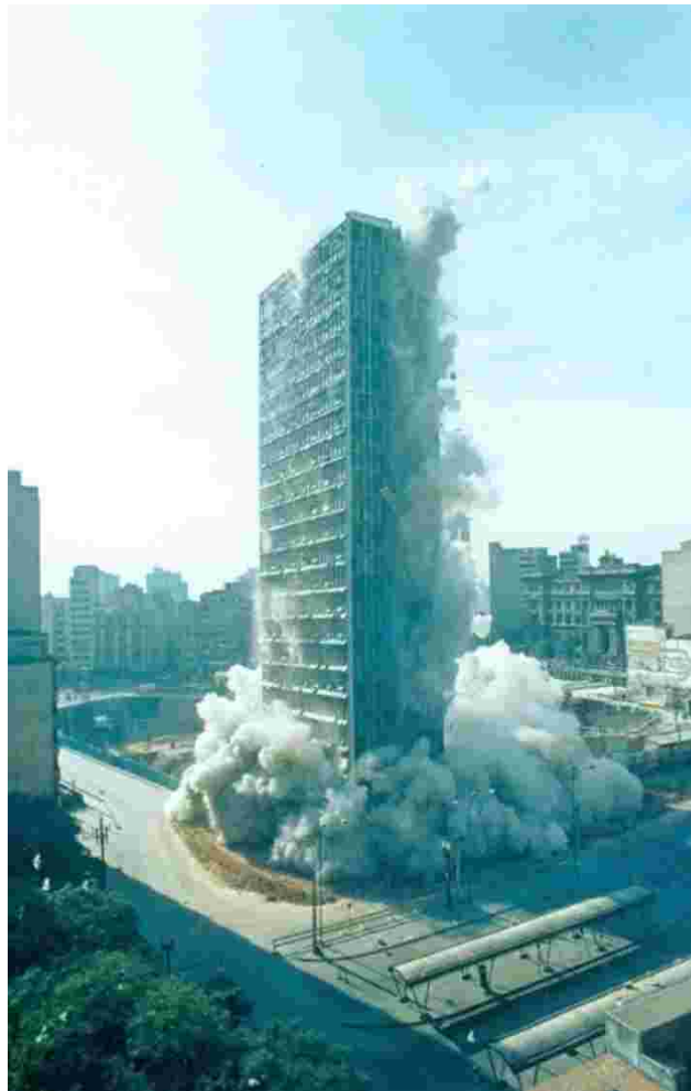
Figura 7 – Implosão do Edifício Mendes Caldeira Fonte: www.saopauloinfoco.com.br/memoria-edificios-sp
