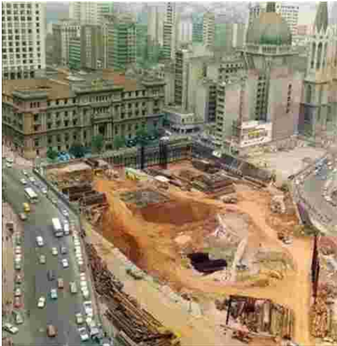
Figura 8 – Obras do Metrô em frente ao Palácio da Justiça. Fonte: https://www.institutodeengenharia.org.br
